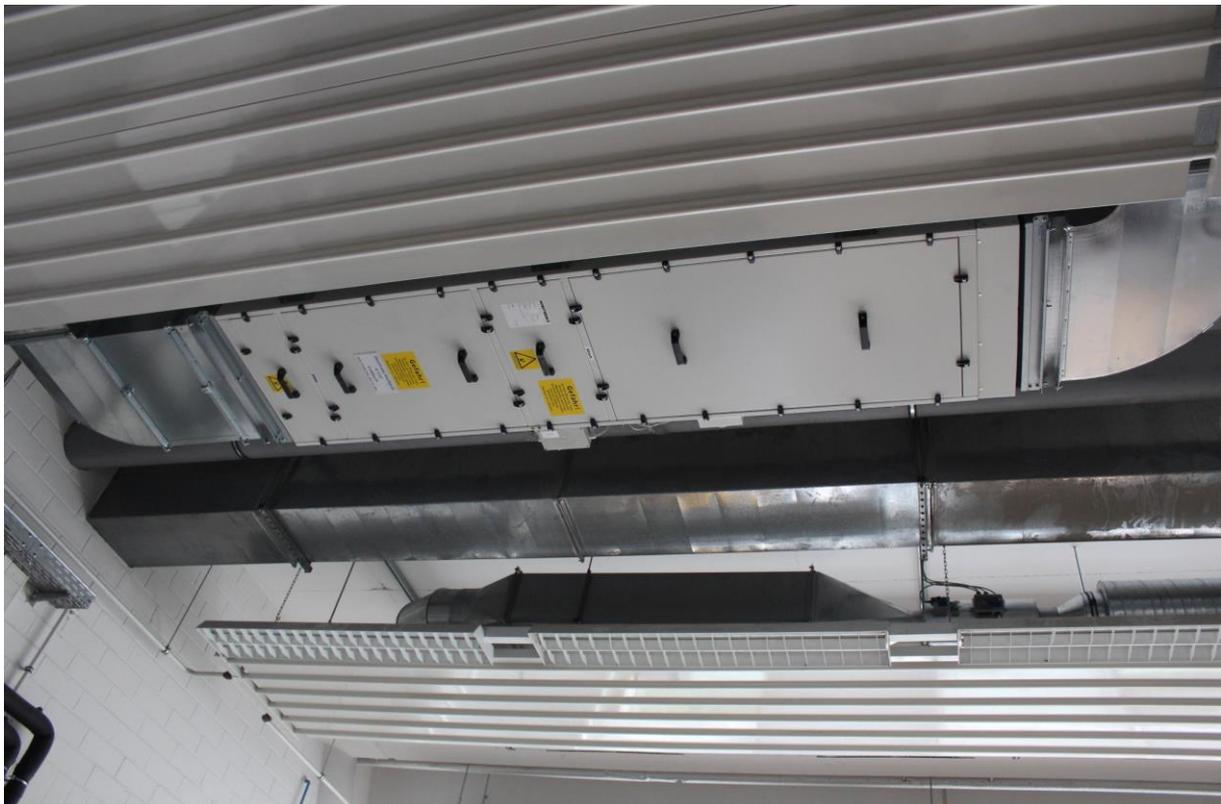
Abbildung 2: Platzierung einer Semizentralen Kompakteinheit in einer Installationsebene mit Beleuchtung und Deckenstrahlplatten
