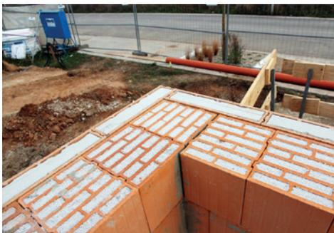
Abbildung 2: Zweischalige Bauweise aus Perlit-gefüllten Ziegeln (Innenseite) und einer zwölf Zentimeter dicken Wärmedämmfassade aus Calostat-gefüllten Vorsatzziegeln [Quelle: TH Nürnberg]
