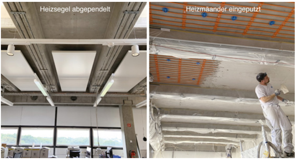
Abb. 2: Integration der Niedertemperatur-Deckenheizsysteme in den Gebäudebestand
