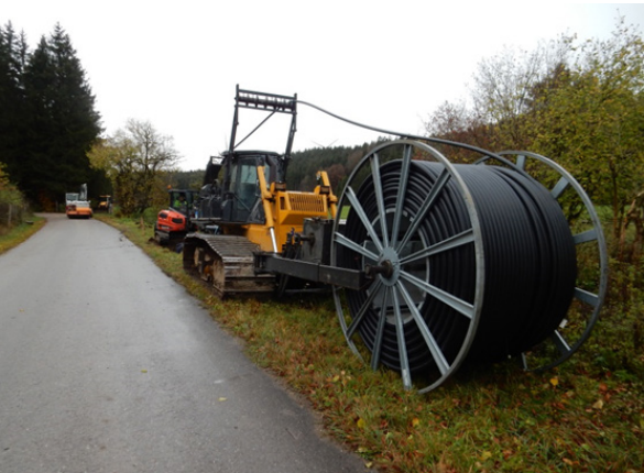
Abb. 1: Kabelverlegung zwischen Windenergieanlagen und Heizzentrale (Ingenieurbüro Sing)
