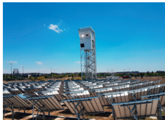
Solarthermochemische Anlage SUN-to-LIQUID in Spanien: Ein Prozessschritt ist die Produktion von Wasserstoff mittels thermochemischem Redox-Zyklus (© DLR)
